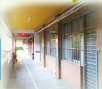
耐震補強後的教室外觀
