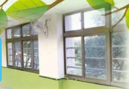
耐震補強後教室牆面
