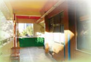
耐震補強後的走道牆面
