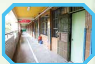
耐震補強前的教室外觀
