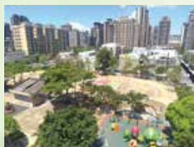
運動場施工中
