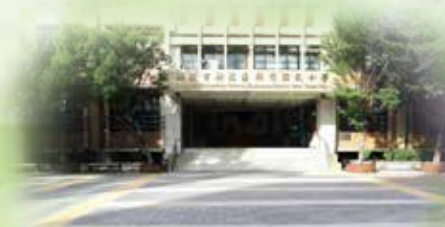
整修完工後地坪
