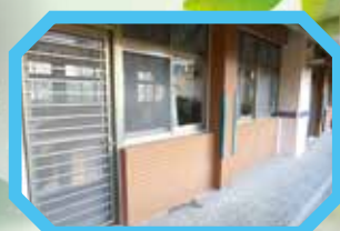
耐震補強後的教室外觀
