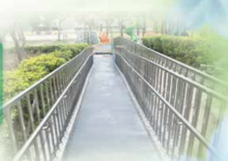
地坪改善工程 - 無障礙坡道完工
