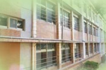
耐震補強後的沐風樓外觀
