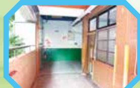
耐震補強前的走道牆面
