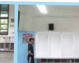
組裝佈告欄主架構
