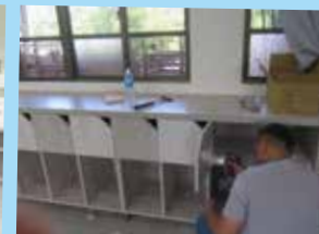
置物櫃安裝門
