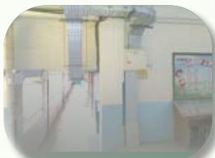
新作電力系統層盤及線槽
