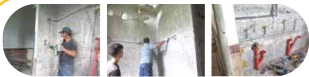
敲打預留管線 安裝管線（電線管） 完成安裝廢水管線
