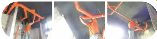
拆除舊廢水管線
