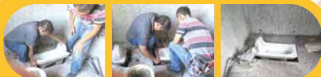
安裝馬桶 丈量位置是否正確 完成馬桶安裝
