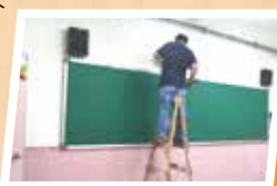
準備拆除佈告欄
